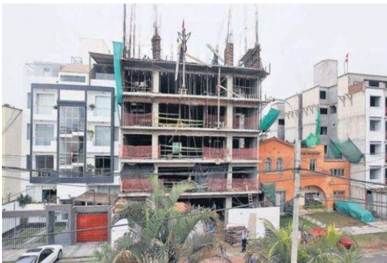
OBRAS CIVILES EDIFICIO – MAGDALENA (S.C)
